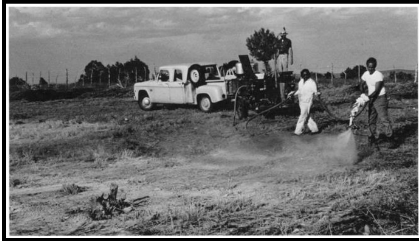
Figura 35. Aplicación de cera parafina sobre la superficie de contribución o captación (Frasier, 1975).
