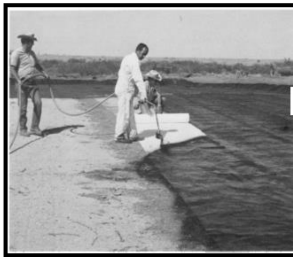
Figura 36. Aplicación de la emulsión asfáltica con una base de fibra de vidrio (Frasier, 1975).
