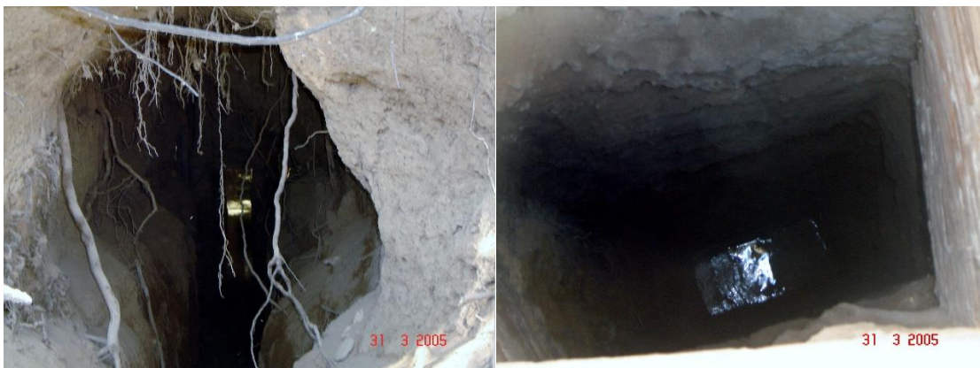
Figura 56. Túneles horizontal y vertical de una galería en Tehuacán, Puebla.
