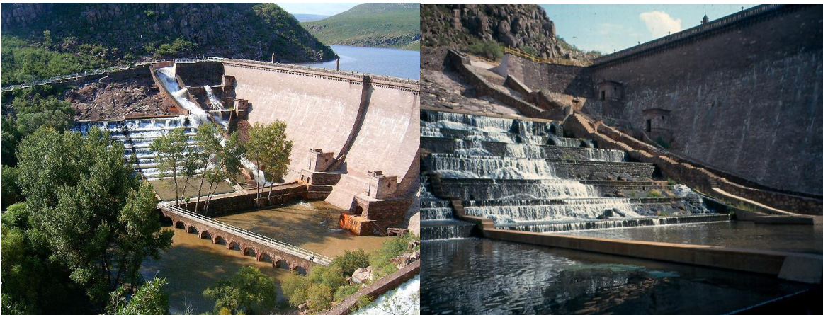
Figura 54. Aspecto de la Presa San José 10 , San Luis Potosí.
