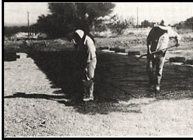
Figura 34. Colocación de la capa de grava (Frasier y Myers, 1983)
