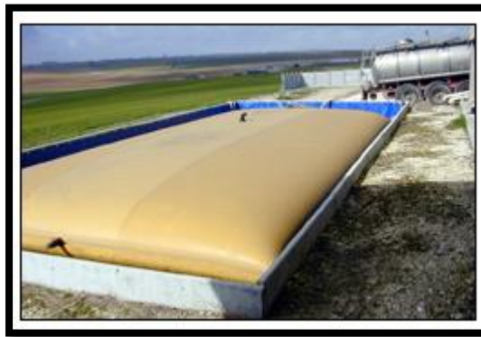
Figura 37. Ejemplo de una bolsa para almacenamiento de agua (bolsa cisterna). 7
