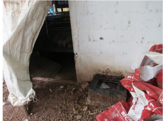
F) Mal posicionamiento de pediluvios en entradas de maternidad.
