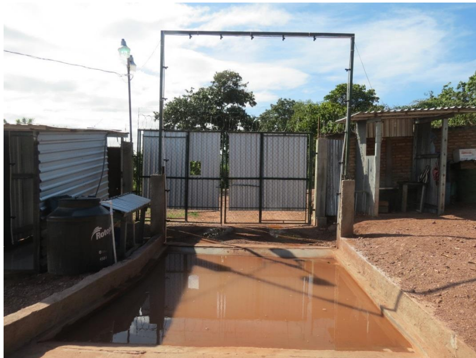
Figura 13. Entrada con arco sanitario y vado o rodiluvio para el control de bioseguridad en la entrada de vehículos en granja Agua Tibia.
