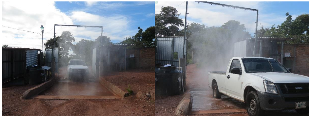
Figura 14. Control de bioseguridad para vehículos en granja Agua Tibia.
