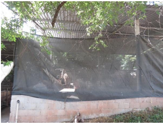
G) Mal posicionamiento de mayas contra aves, deberá cubrir todos los espacios abiertos.
