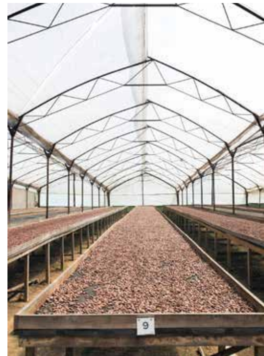
Figura 22. Invernaderos con estructura metálica y camas levantadas
