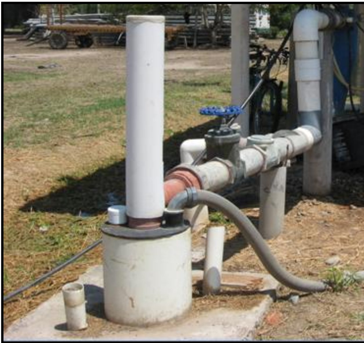
Pozo, perforación hasta el acuífero. 100 m de profundidad
